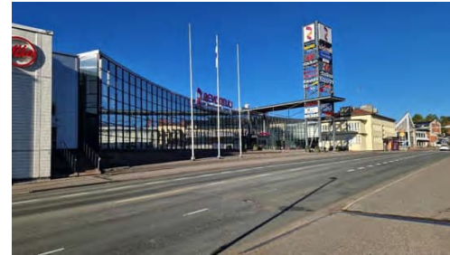
Kuva 3. Kauppakeskuksen julkisivu ja edustan aukio Koskikadulta.
